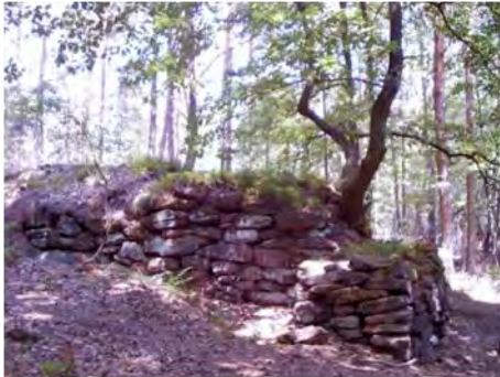
Abb. 8 Heidenschuh bei Klingenmünster, Torbereich, eigene Aufnahme
