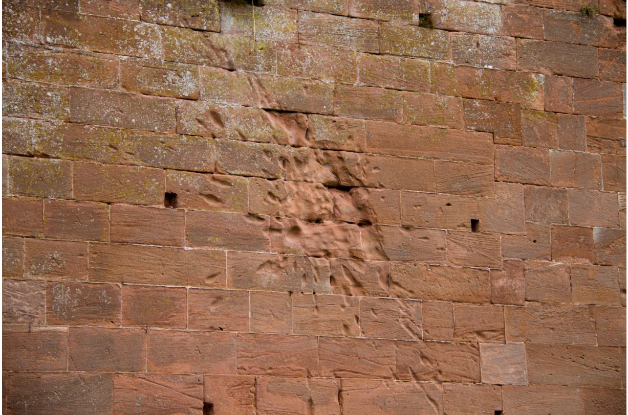
Abbildung 9: Beschussspuren an der Ummauerung des Hauptfelsens, vermutlich aus 1870, Aufnahme des Autors; hier ist auch ein Steinmetzzeichen zu finden, ein großes „A“
