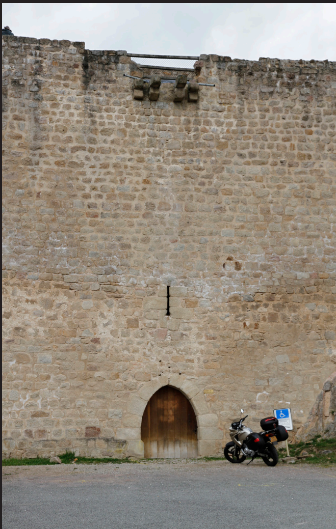
Oben: Alter Eingang zur Burg mit Schlitzscharte und Gusserker
