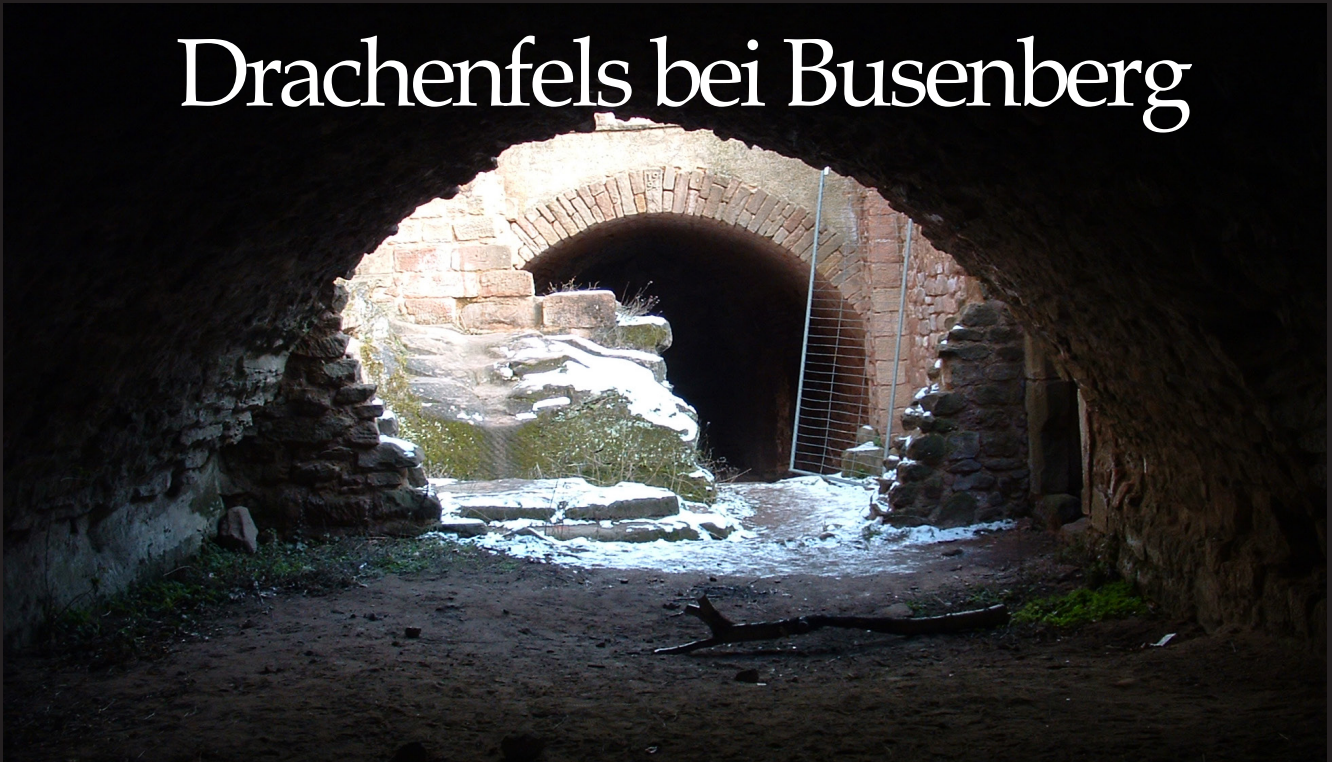
Blick vom östlichen Keller hinüber zum Brunnenkeller im Ostgebäude
